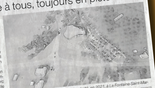
P.R. Vue aérienne du projet Aux Cirques, implanté, en 2021, à La Fontaine-Saint-Martin, le long de la D323. (Credit photo: Norinia France)
